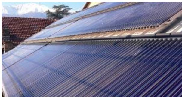
Figura 2 – Esempio di collettore solare a tubi sottovuoto
